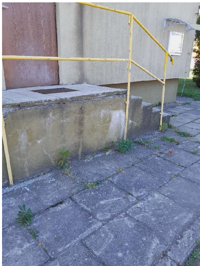
Schody od strony elewacji północnej
