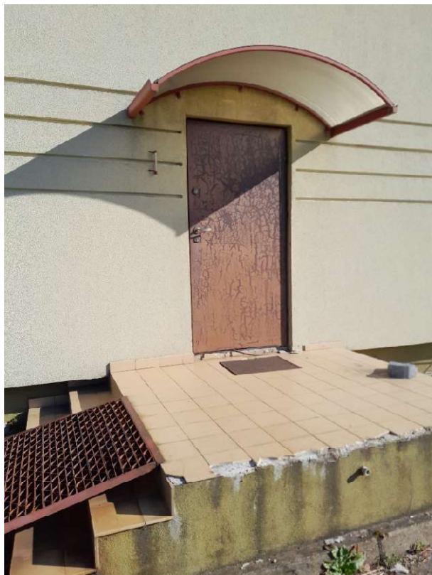
Schody od strony elewacji południowej
